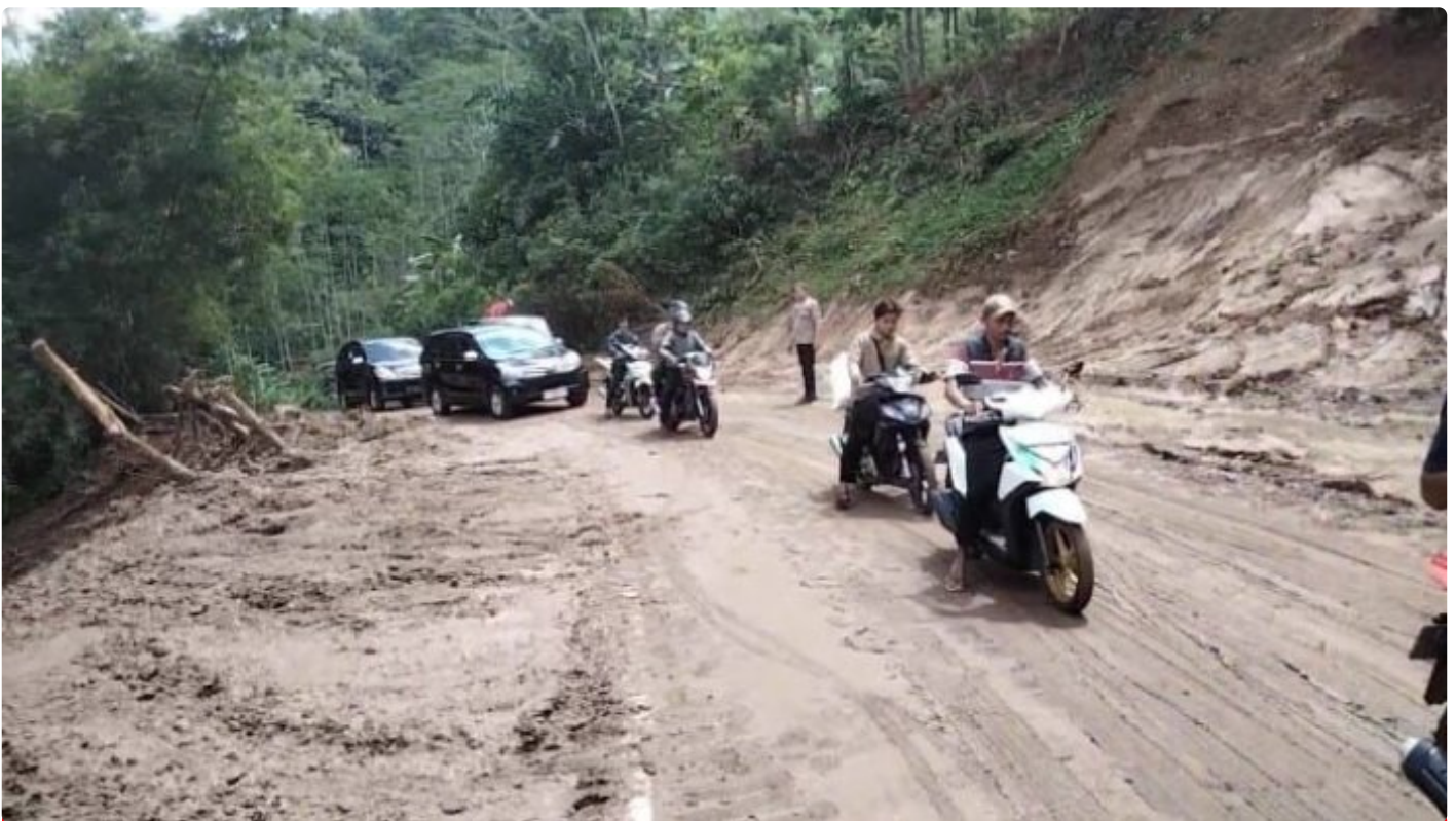
Pembukaan Jalan Selajambe-Cipasung Paska Longsong Yang Menutup Jalan
